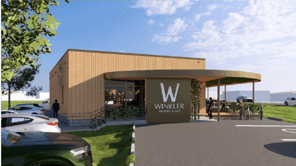
In den Backstuben der Traditionsbäckerei Winkler stehen natürliche Zutaten, lange Teigruhen und handwerkliche Verarbeitung im Mittelpunkt. (Bild: Bäckerei Winkler)
